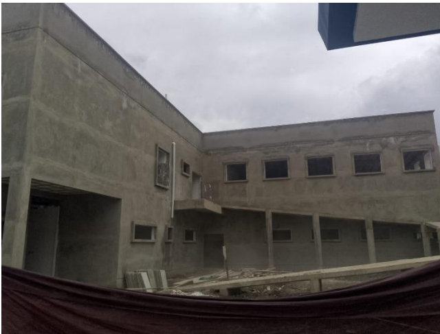
Fachadas con revoque de cemento
