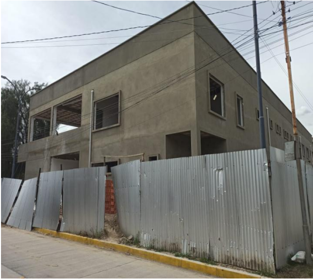
Fachadas con revoque de cemento
